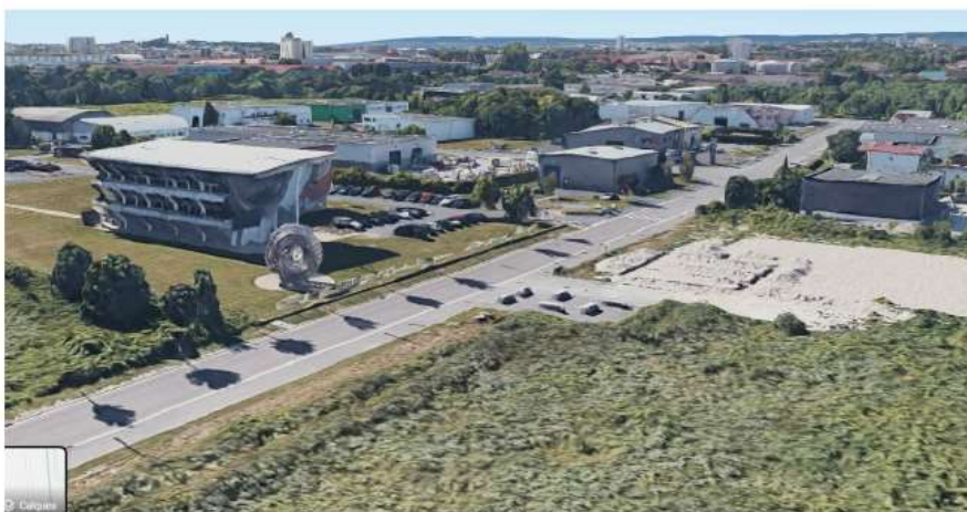
2 - Depuis l'avenue de la Malle
